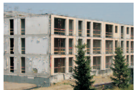
Die 6-geschossigen Häuser wurden auf 3 bzw. 4 Etagen zurück montiert.
