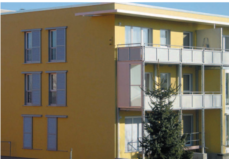
Die 6-geschossigen Häuser wurden auf 3 bzw. 4 Etagen zurück montiert.
